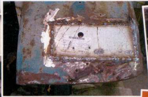
Frisch eingeschweißtes Blech.
